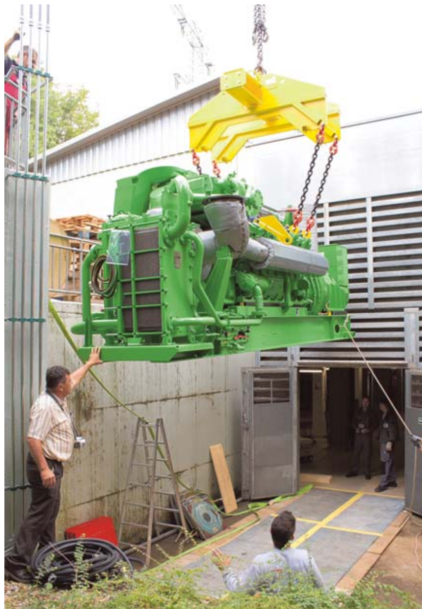
Der 14 Tonnen schwere Motor wurde per Kran und anschließend mit Luftkissen an seinen endgültigen Standort befördert. Links im Bild: Technischer Leiter Bernhard Matt. BILD: VON APPEN
