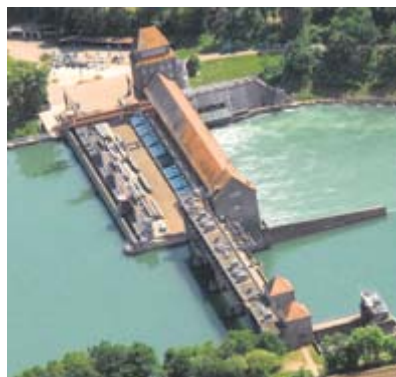
Produziert seit über 100 Jahren Strom: Das Rheinkraftwerk.
