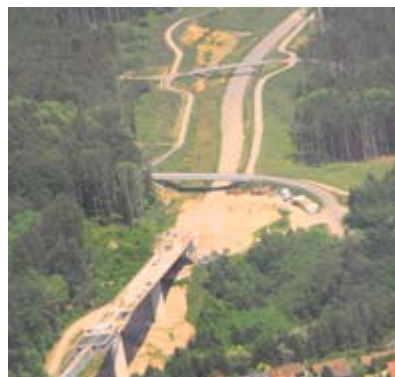
In zwei Jahren rollen hier Autos: Großbaustelle Andelsbachbrücke.
