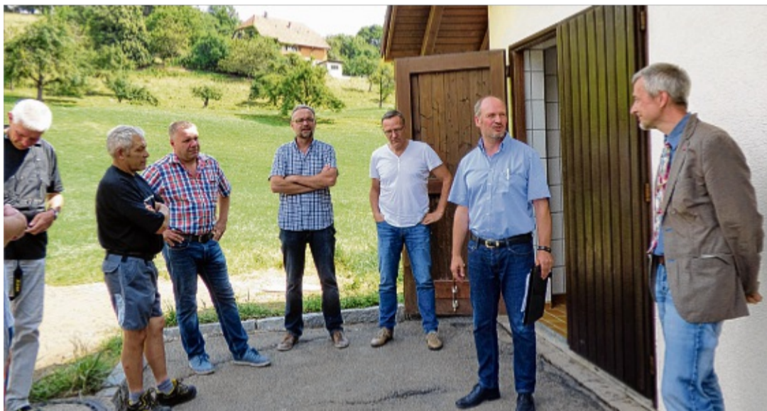
Bei der offiziellen Inbetriebnahme des neuen Abwasserpumpwerks erwähnte Michael Fackler vom Regierungspräsidium Freiburg auch die höhere Wirtschaftlichkeit von Großkläranlagen, von der so Bürgermeister Stefan Kaiser (von rechts) auch die Einwohner über die Abwassergebühren profitierten. BILD: DORIS DEHMEL
