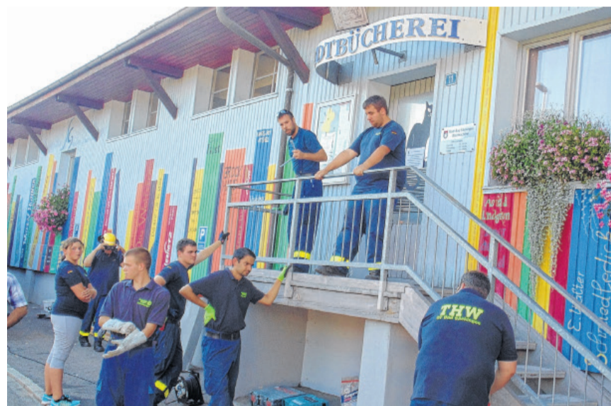
Mitarbeiter des THW montieren das Geländer an der Stadtbücherei ab: Am Freitag ging die Vorarbeit für die Installation einer Rampe über die Bühne, durch die der Zugang barrierefrei werden soll. BILD: MICHAEL GOTTSTEIN
